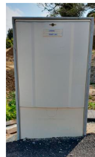
Borne REMBT posée dans une niche au sol avant la construction de la murette
