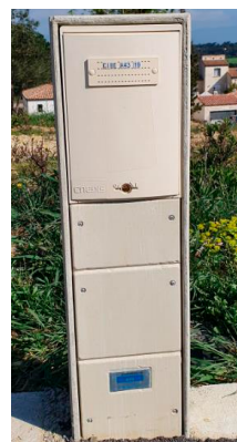
Coffret CIBE posé dans une niche au sol. Avant et Après la construction de murette
